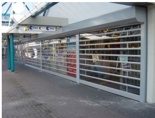
Afbeelding 48 rolleluik voldoet / bak en geleiders voldoen niet
