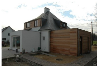
Afbeelding 9 aanbouw voldoet niet
