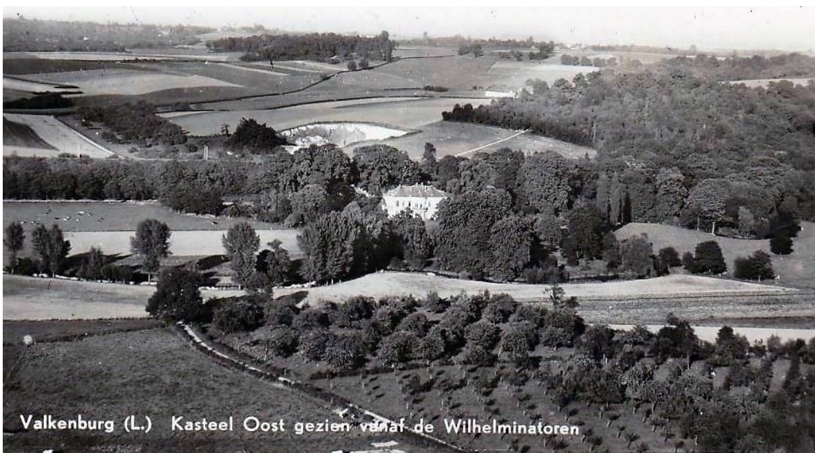
Valkenburg (L.) Kasteel Oost gezien vanaf de Wilhelminatoren Luchtfoto, genomen vanaf de Wilhelminatoren, toont ons het gehele landgoed, met solitair langs de Geul. Bron: Collectie S. Jacobs.
